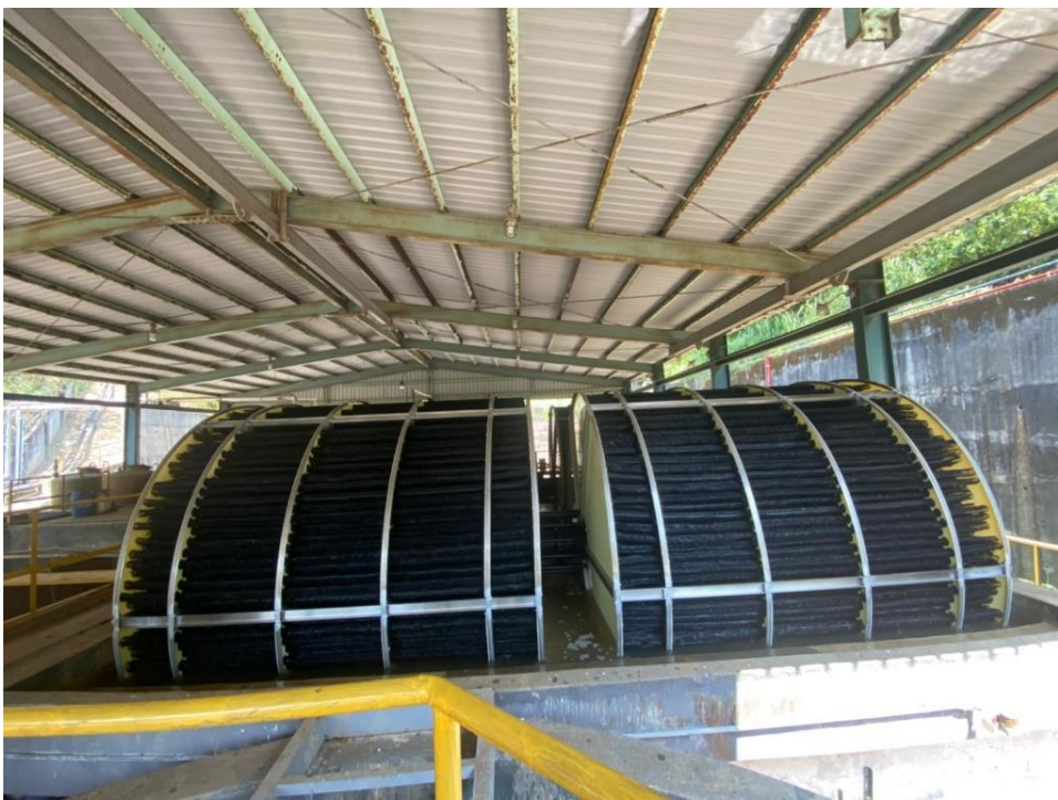
圖 3-7 網狀式旋轉生物圓盤之實場應用
